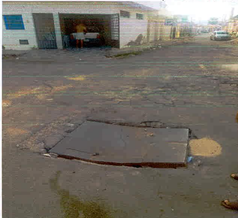
FOTO TAMPA DO BUEIRO PERIMETRAL III, PERPÉTUO SOCORRO
