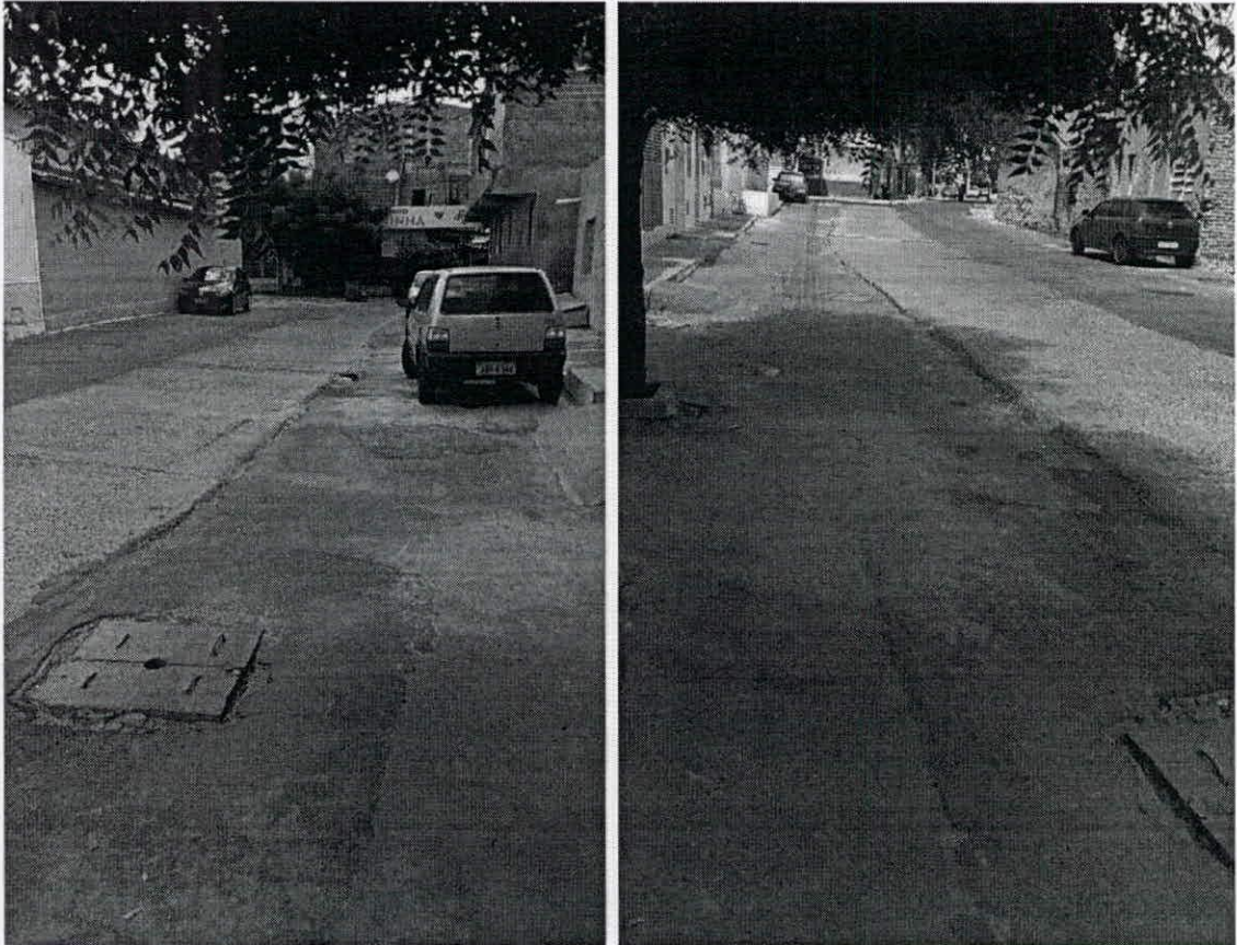
Anexo I _ Rua Drº Manoel Barros de Freitas, Bairro Centro.
