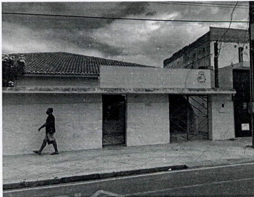
Anexo I – Fachada, CAPS II - Avenida da Marçonaria, nº 47, Bairro Perpétuo Socorro
