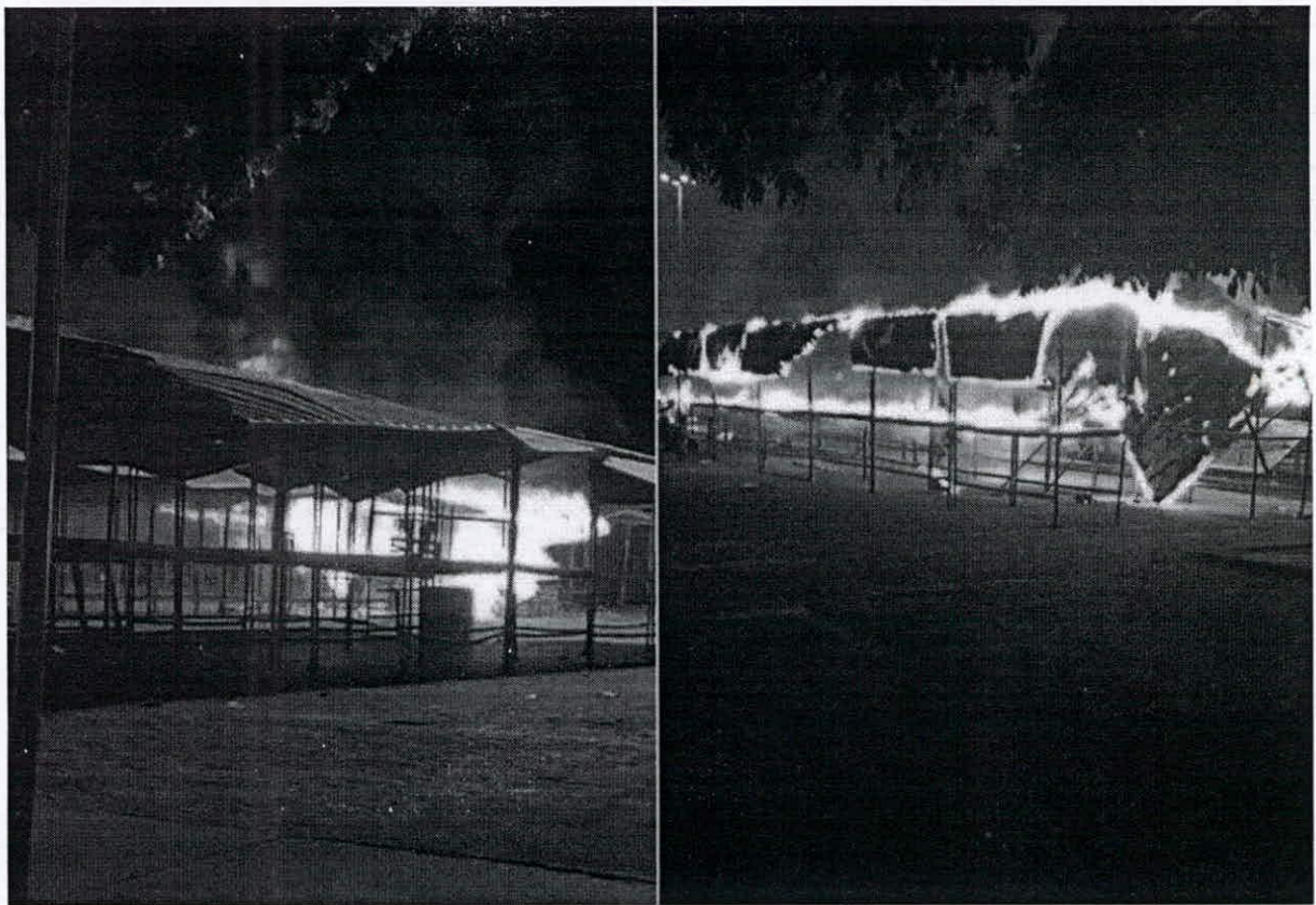
Barracas que foram atingidas por incêndio em 01 de agosto do corrente ano.
