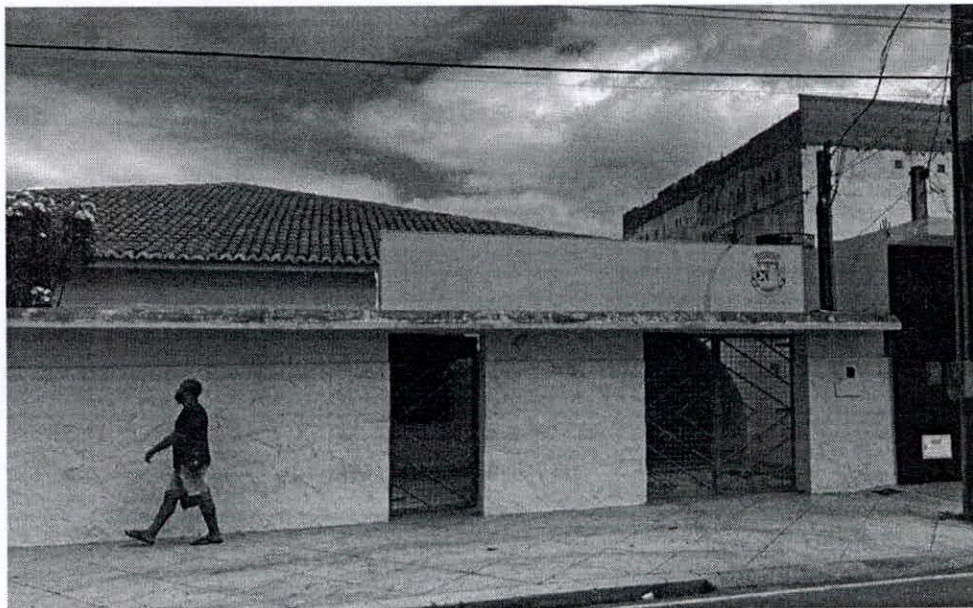
Anexo I – Fachada, CAPS II - Avenida da Marçonaria, nº 47, Bairro Perpétuo Socorro
